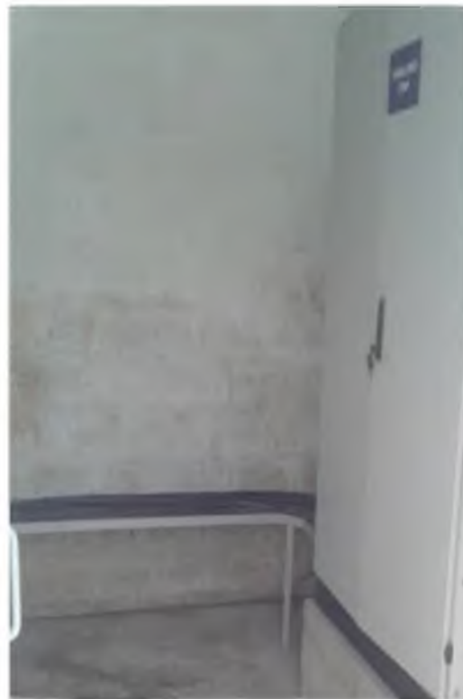
Figura 5.9 Exterior del panel principal de distribución Fuente: El autor
