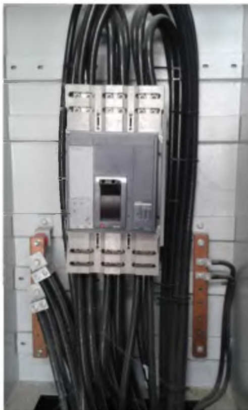
Figura 2.1 Disyuntor principal Fuente: El autor
