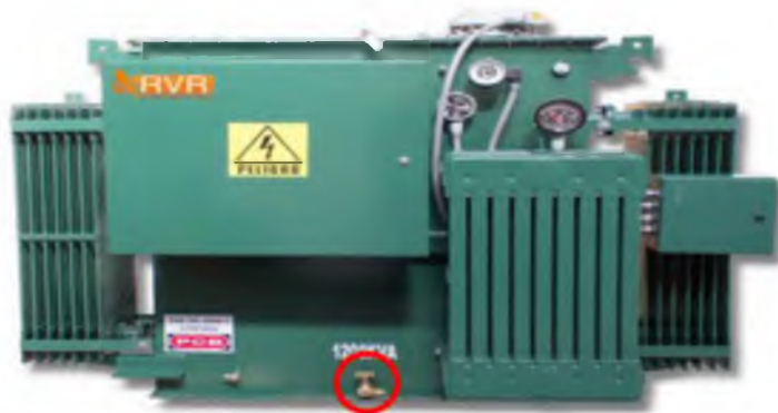
Figura 2.20: Válvula combinada para drenaje, filtrado y muestreo de aceite.
