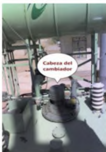
Figura 2.10: Cambiador de TAP bajo carga de MaschinenFabrik Reinhausen (MR). Fuente: Ing. Gabriel Horacio Orellana
