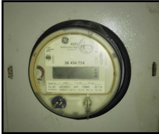
*Figura N° 3.6 “Medidor eléctrico CL-20”*
