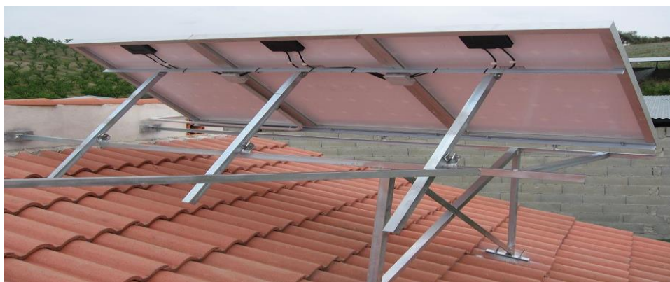
Figura 7 Caja de Conexiones de Paneles Solares
