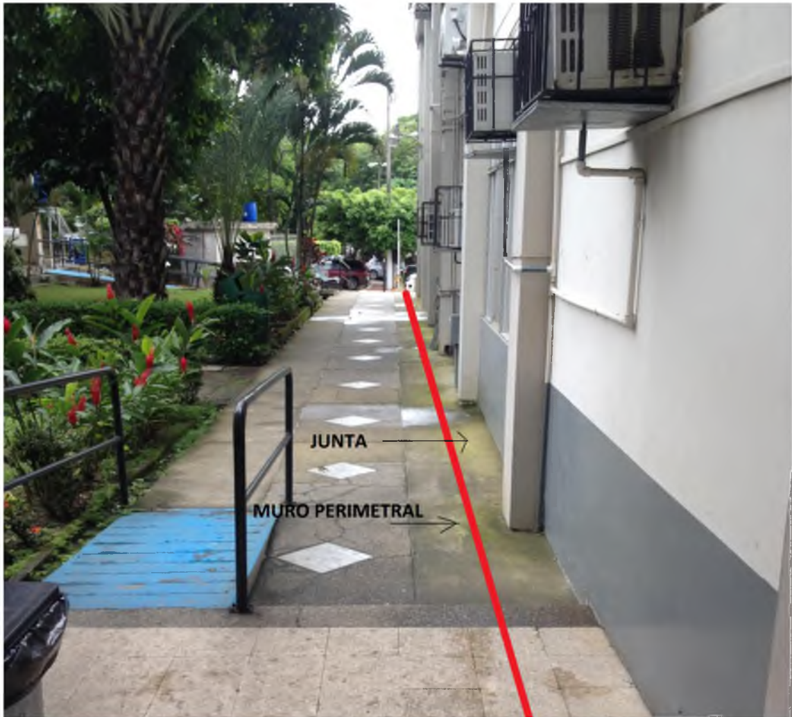
Figura 181. Vista posterior de la Facultad – Muro perimetral y Junta
