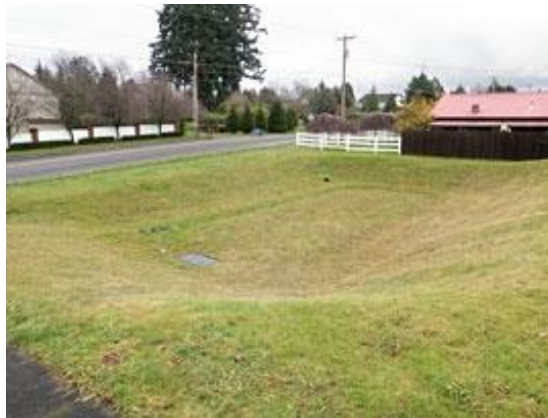
Gráfico 8: Vista superficial de un depósito de infiltración.
