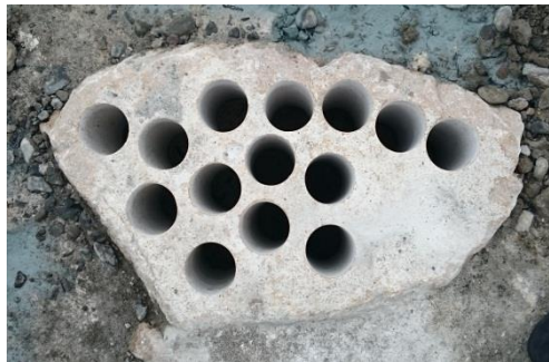
Figura 3.1: Roca recién barrenada
