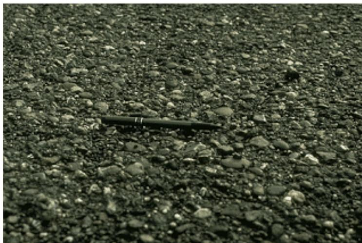
**Figura 2.12. Desprendimiento en pavimento**
