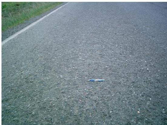
**Figura 1.2. Peladura en Capa Asfáltica**
