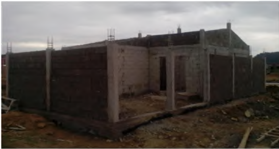
Proceso constructivo de Villa. Modelo B. Ciudadela La Joya Etapa Gema. Daule- Ecuador
