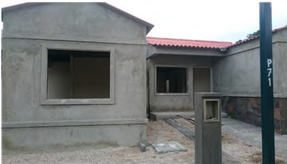
Proceso constructivo de Villa. Modelo H. Ciudadela La Joya Etapa Corona. Daule-Ecuador
