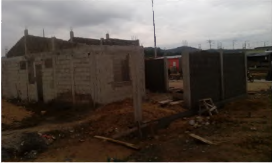
Proceso constructivo de Villa. Modelo B. Ciudadela La Joya Etapa Gema. Daule- Ecuador
