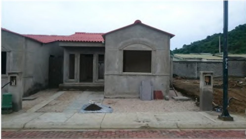
Proceso constructivo de Villa. Modelo G. Ciudadela La Joya Etapa Corona. Daule-Ecuador
