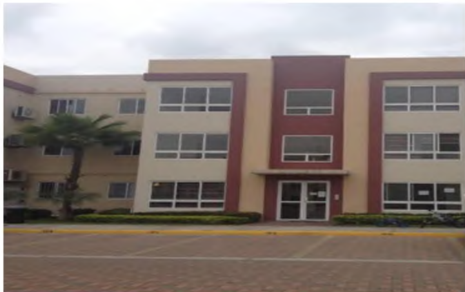
Conjunto Residencial . Via a la Costa. Guayaquil-Ecuador
