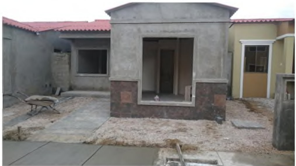
Proceso constructivo de Villa. Modelo I. Ciudadela La Joya Etapa Corona. Daule-Ecuador
