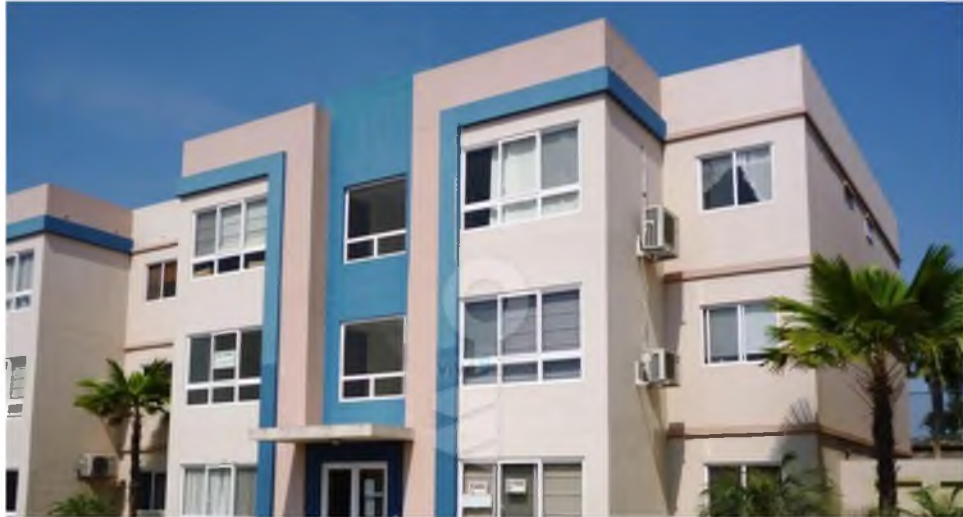
Conjunto Residencial . Via a la Costa. Guayaquil-Ecuador
