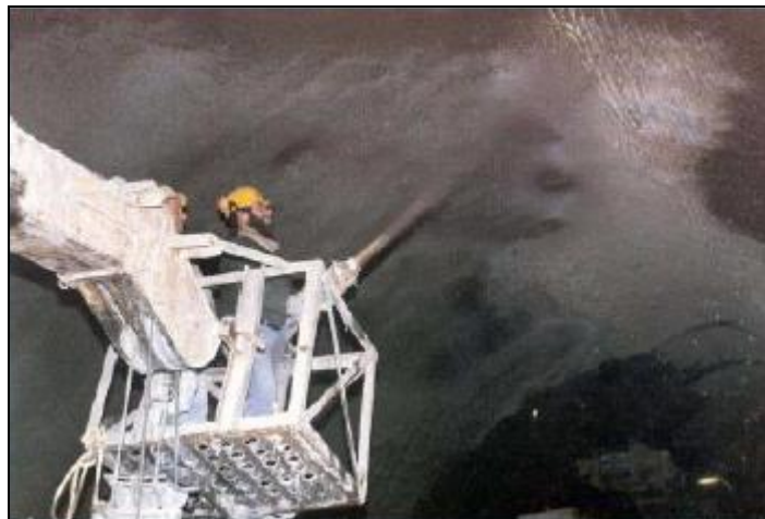
Figura 4.1. Aplicación del hormigón proyectado (referencia 4.2).
