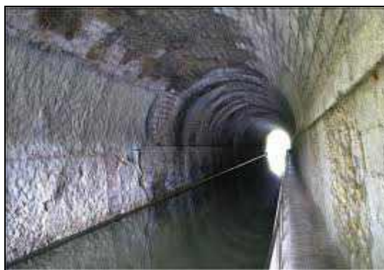
Figura 2.6. Vista del interior del túnel de Malpas. (tomada de Wikipedia).
