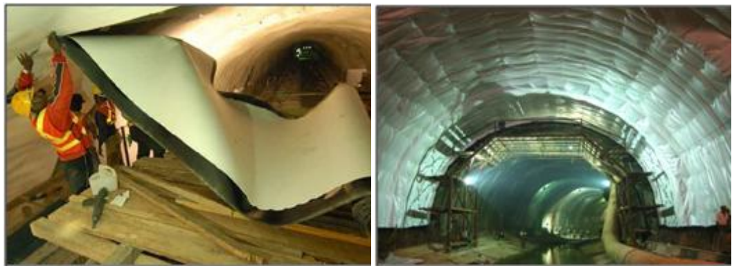
Figura 5.7. Instalación geotextil entre el sostenimiento (izquierda) y el revestimiento (derecha).
