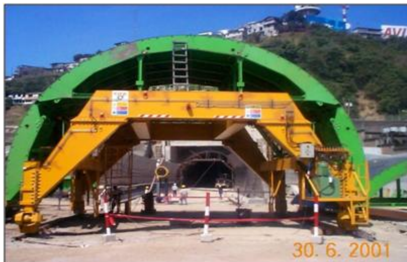
Figura 5.2. Estructura de arco para encofrado del revestimiento definitivo.
