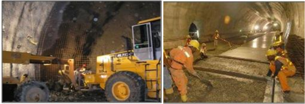
Figura 5.6. Colocación del sostenimiento (izquierda) y fundición del pavimento (derecha)
