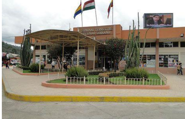
Figura 3: Terminal Terrestre de Cuenca Fuentes: Diario El Tiempo (2015)
