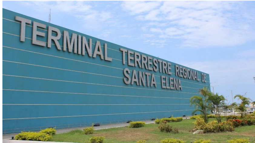
Figura 10: Terminal Terrestre de Santa Elena Sumpa
