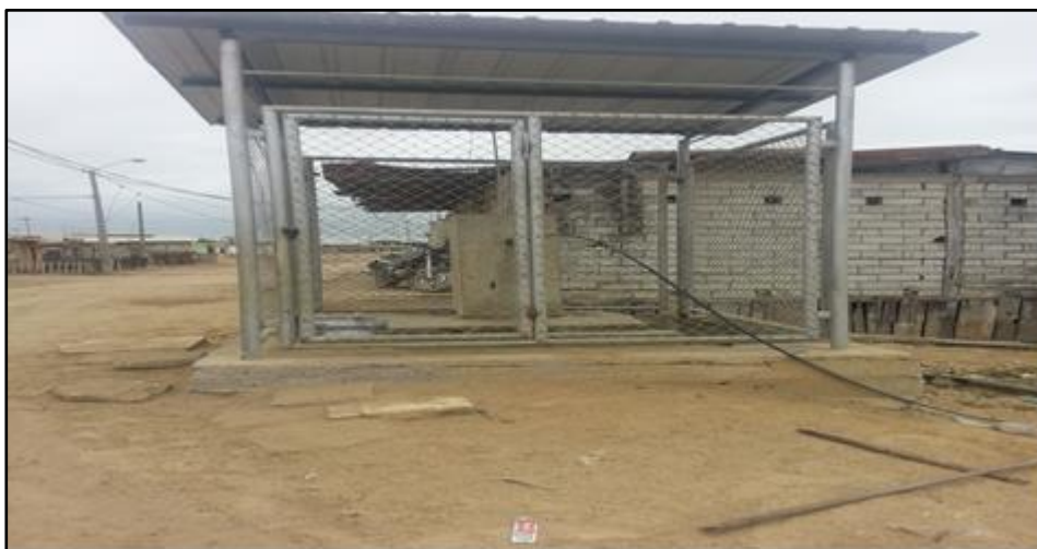
Figura1: Fuente de Agua Potable Fuente: El autor
