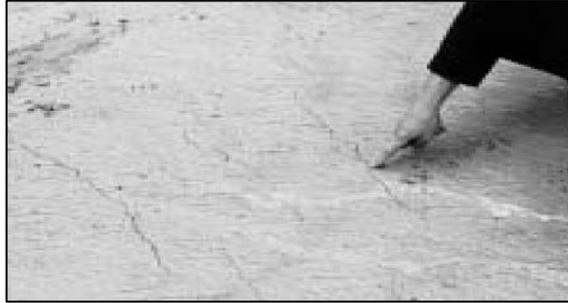
**Fig.3. 2** Agrietamiento por contracción plástica.
