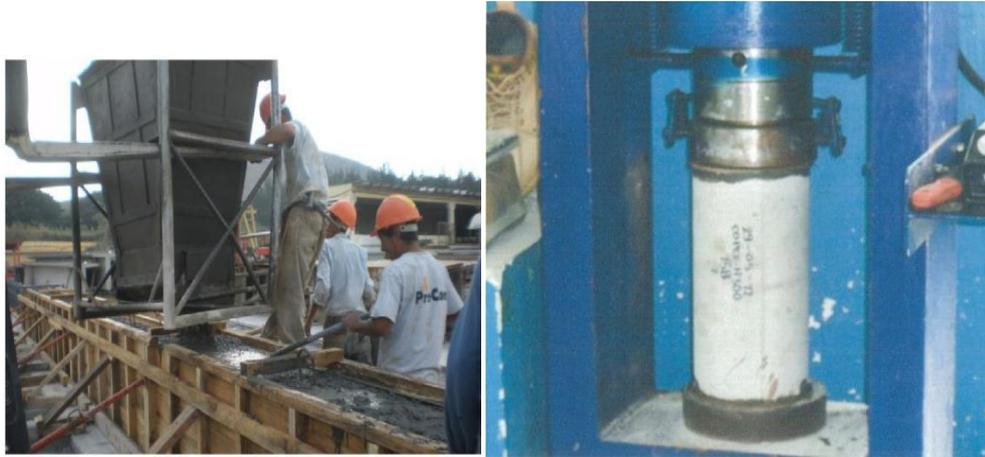
**Fig. 5. 8 Pasos 5 y 6: Colocación de hormigón - Control de calidad. Fuente APG**
