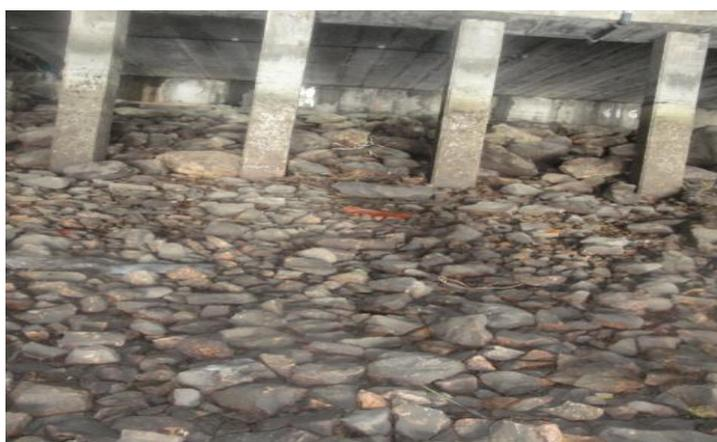
Fig.3. 43 Talud del muelle del Puerto de Guayaquil
