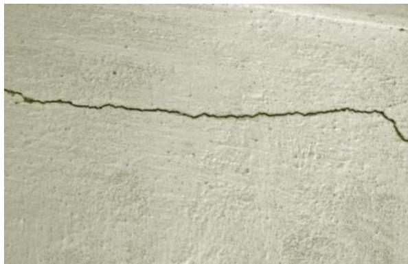
Fig.3.6 Cuarteadura en muro.
