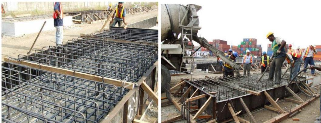
**Fig. 5. 9 Fotos de trabelosas armado y fundición**
