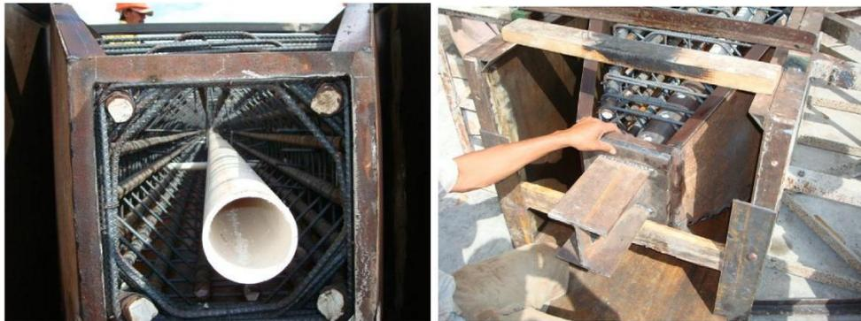
**Fig. 5. 7 Pasos 3 y 4: Encofrado instalación de Chiflón- Colocación de puntal o regatón. Fuente APG**
