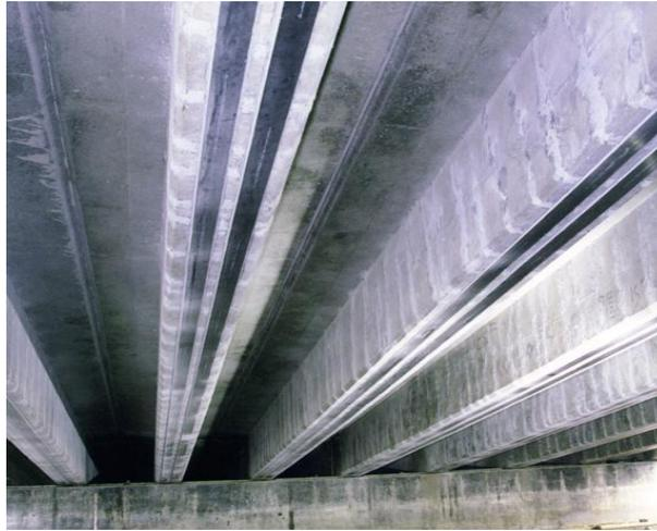
**Fig. 5. 19 Foto de colocación de fibras de carbono.**
