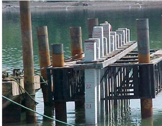
**Fig. 5. 12 Estructura falsa para descabece de pilotes**
