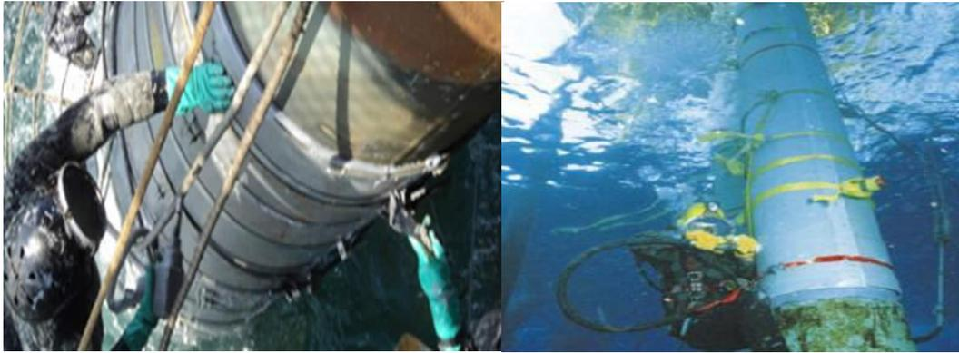
Fig. 5. 18 Fisura de trabajo de aplicación de protección contra la corrosión
