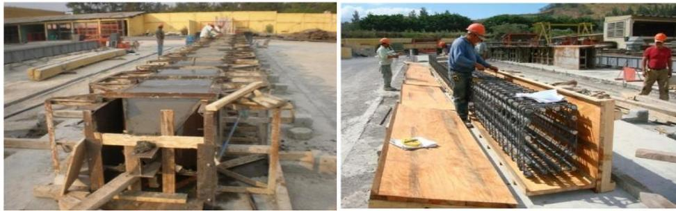
**Fig. 5. 6 Pasos 1 y 2: Encofrado para hormigonado y armado de estructura. Fuente APG**
