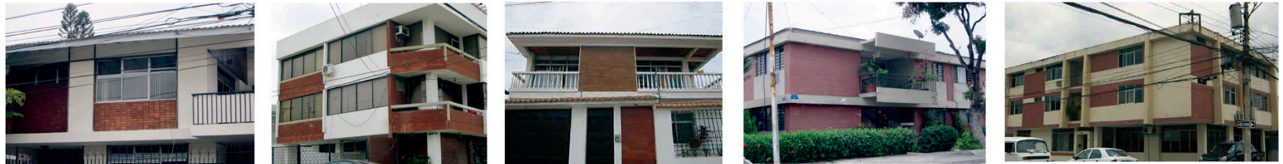
Figura 48: Utilización del ladrillo en fachada en residencias de urdesa. Fuente: Elaboración propia
