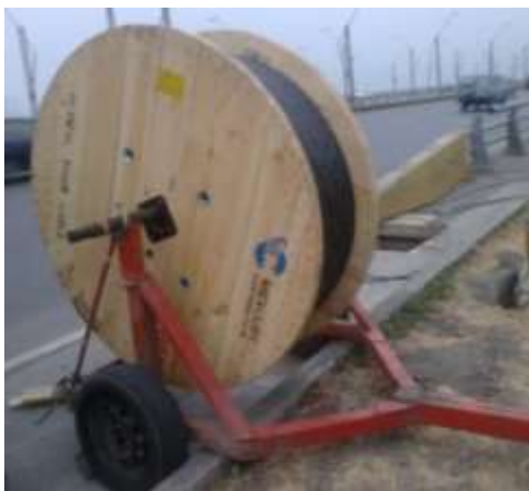
Figura No.4.8: Fotografía donde se observa el tendido de un cable de 48 fibras subterráneo en un portabobinas.
