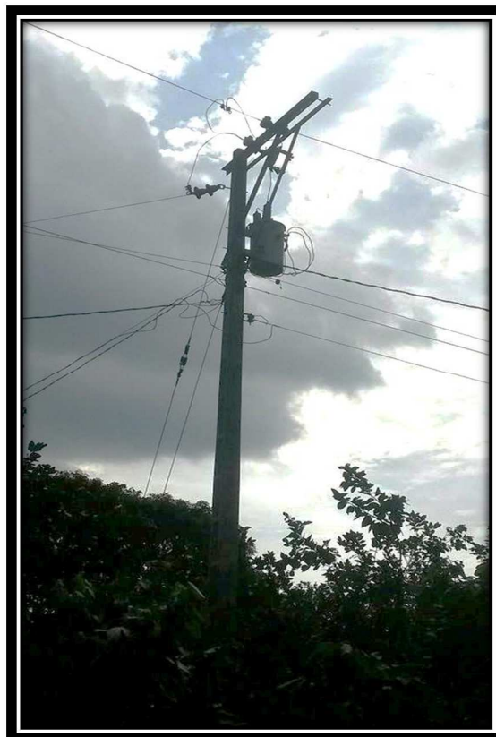
Figura: 26. Monofásica – En Volado – Doble Retención.
