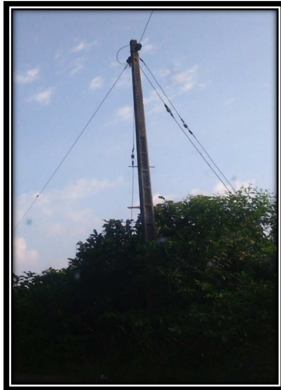
Figura: 21. Monofásica – Retención – Terminal
