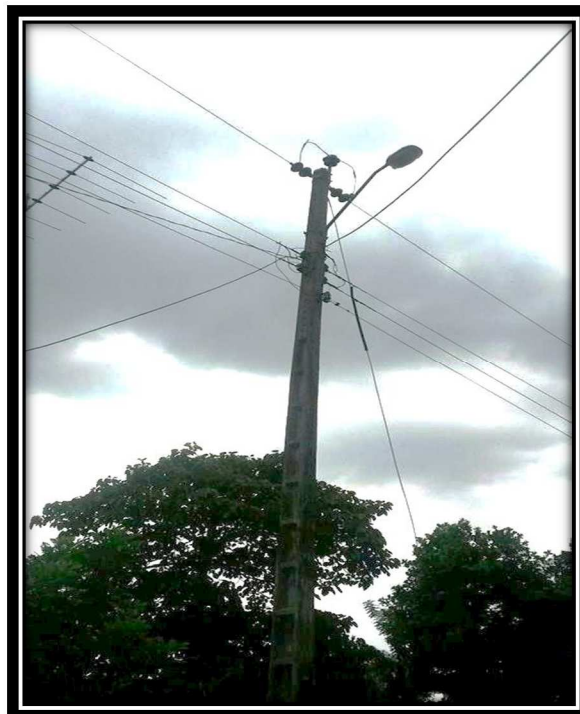
Figura: 25. Monofásica – Centrada – Doble Retención
