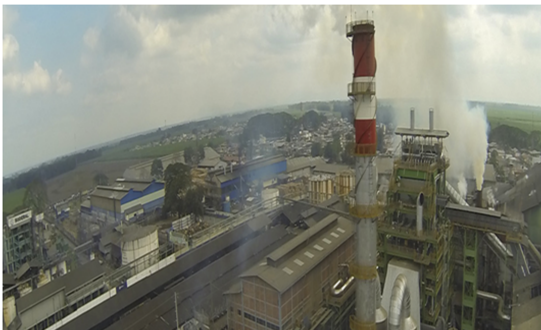
Figura 7. 1 Planta de cogeneración del Ingenio San Carlos. Fuente: I.S.C. Ingenio San Carlos (2012)
