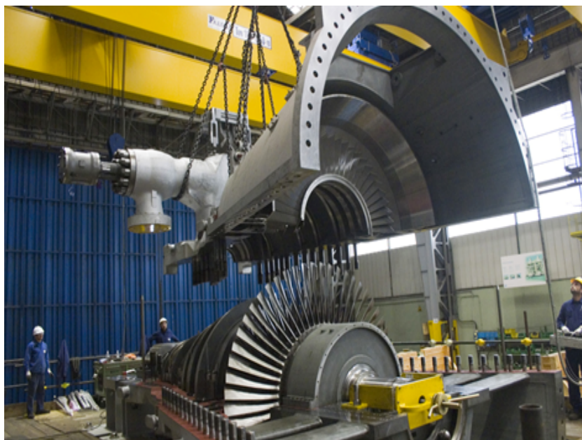
Figura 6. 3 Montaje de una turbina a vapor Fuente: COSAG (2012)
