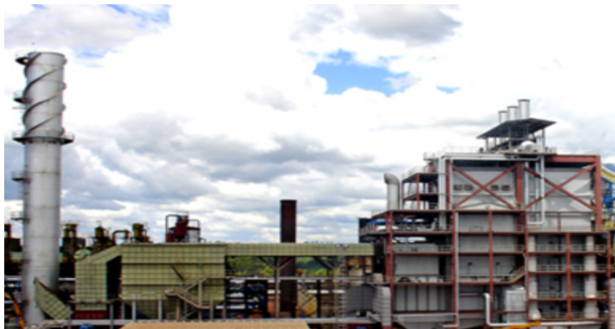
Figura 6. 6 Caldera de compañía Caldema con capacidad de 300Tn/h de vapor a una presión de 65kfg/cm 2
