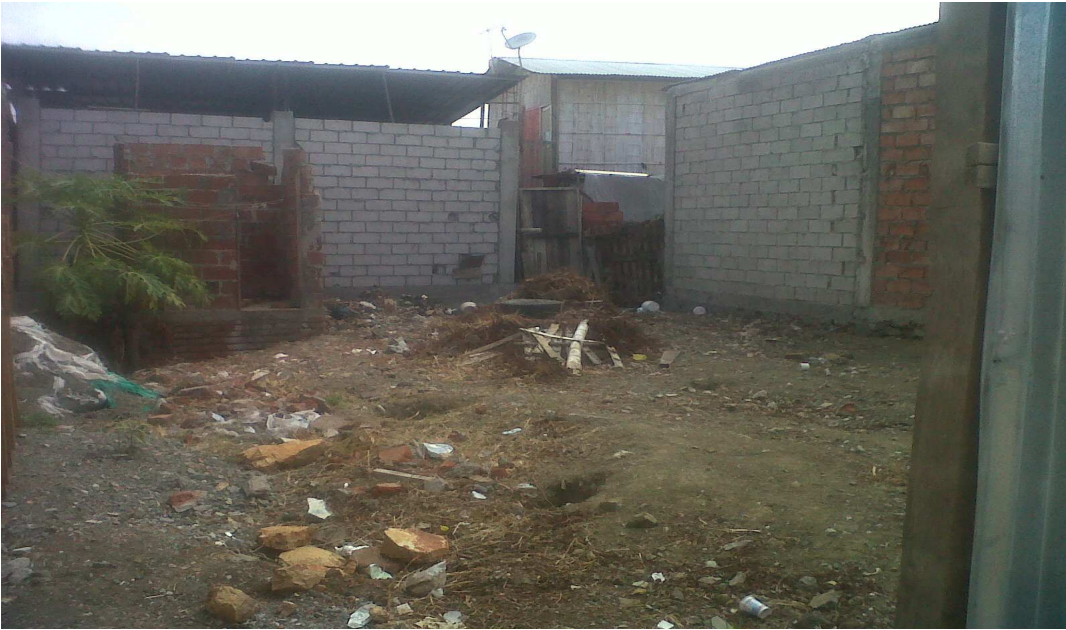
Anexo 9. Terreno aledaño con desperdicios
