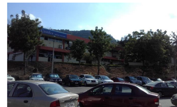
Imagen 12: Edificio de aulas Facultad de Economía Fuente: Autora del proyecto (2014)
