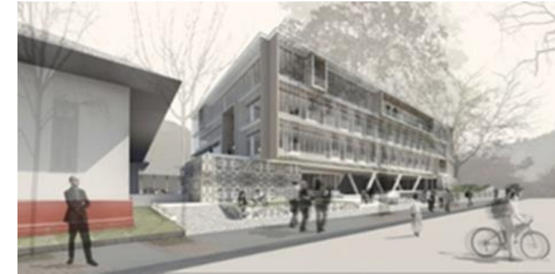
Imagen 40: Vista exterior del edificio Fuente: González, (2013)
