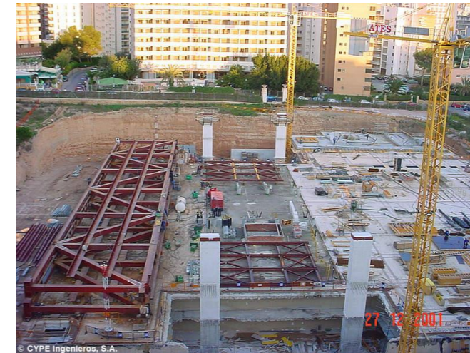
Imagen 31: Montaje de estructura Fuente: Muñoz, (2011)
