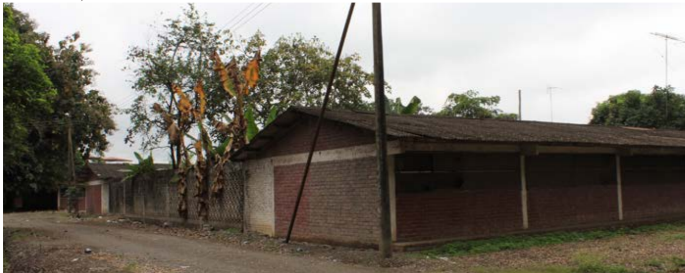
Figura 35. Infraestructura existente. Fuente. Villacres, 2014.
