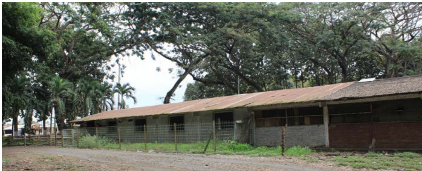
Figura 34. Infraestructura existente. Fuente. Villacres, 2014.
