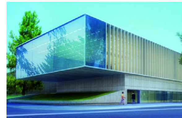
Figura 50. Ventanales y elementos de protección solar Fuente: Comunidad de Arquitectura y Diseño, 2014
