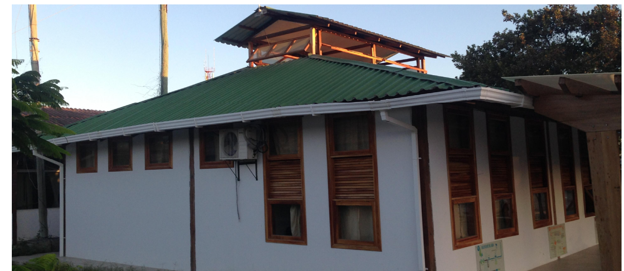
Figura 66. Cubierta de zinc Fuente: Quimbiulco, 2014
