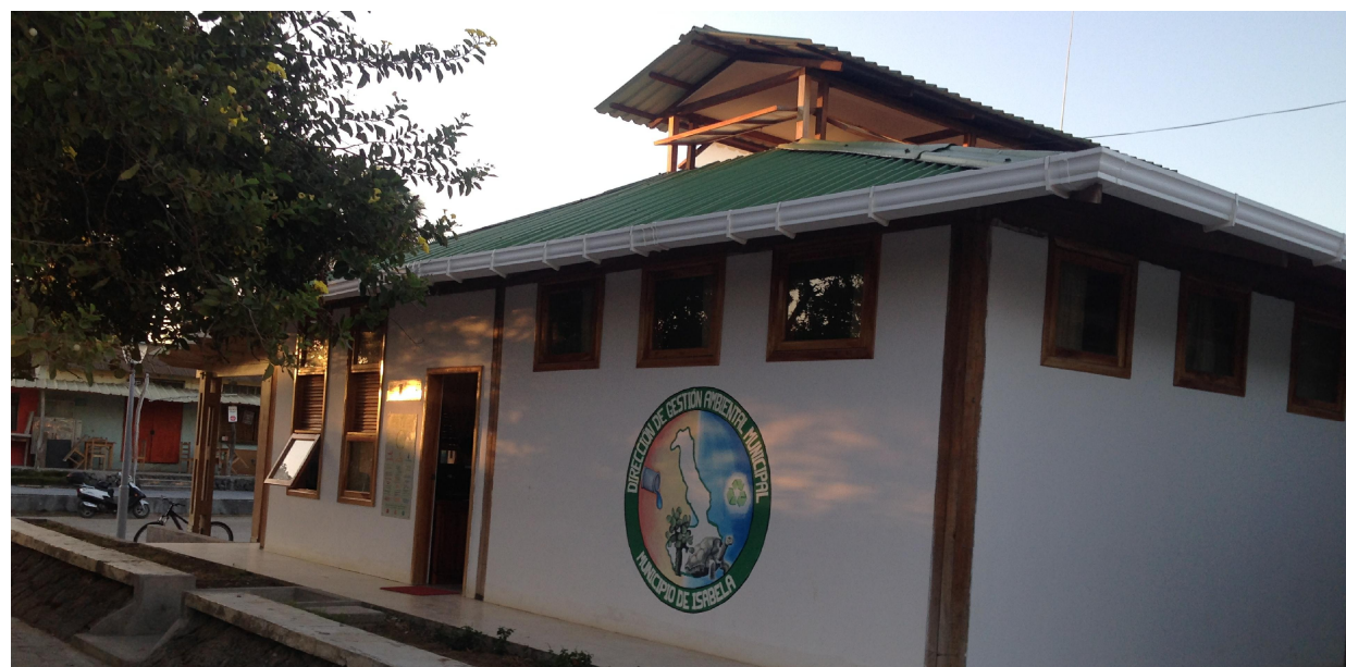
Figura 55. Edificio Oficinas de Gestión Ambiental Fuente: Quimbiulco, 2014
