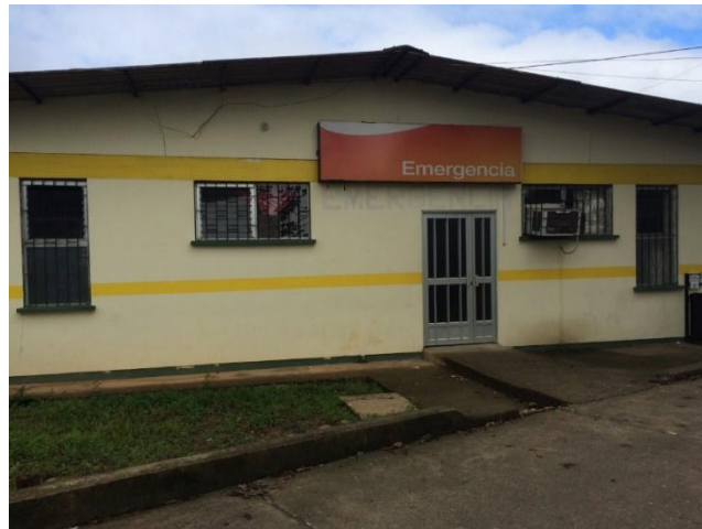
Figura 9: Área de Emergencias Hospital Dr. Humberto Molina Astudillo Fuente: Imágenes propias
