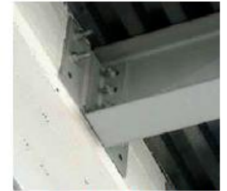
PLACAS METÁLICAS EN COLUMNA
