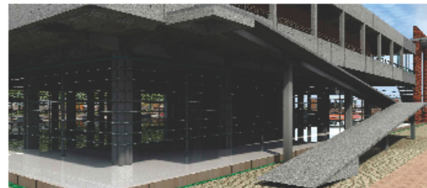
VISTA DE RAMPA
