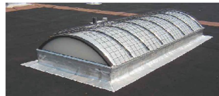
PROYECTO REALIZADO - IMPERMEABILIZACIÓN DE ESQUINAS CON CHOVA ASFALUM
