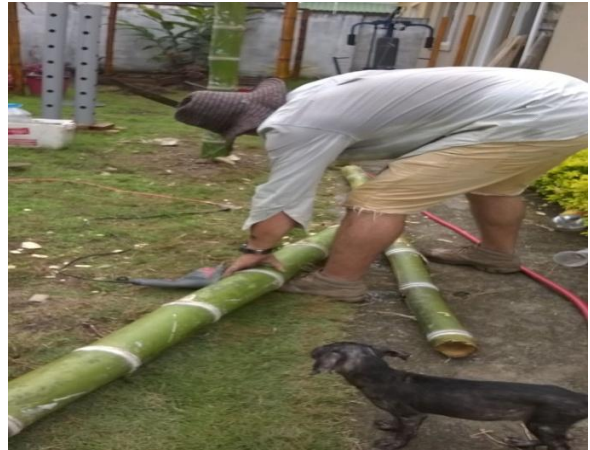
Foto 20. Construcción de prototipo OB3 a base de caña cuadra.
