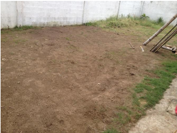
Foto 3. Estado del terreno después de la limpieza.
