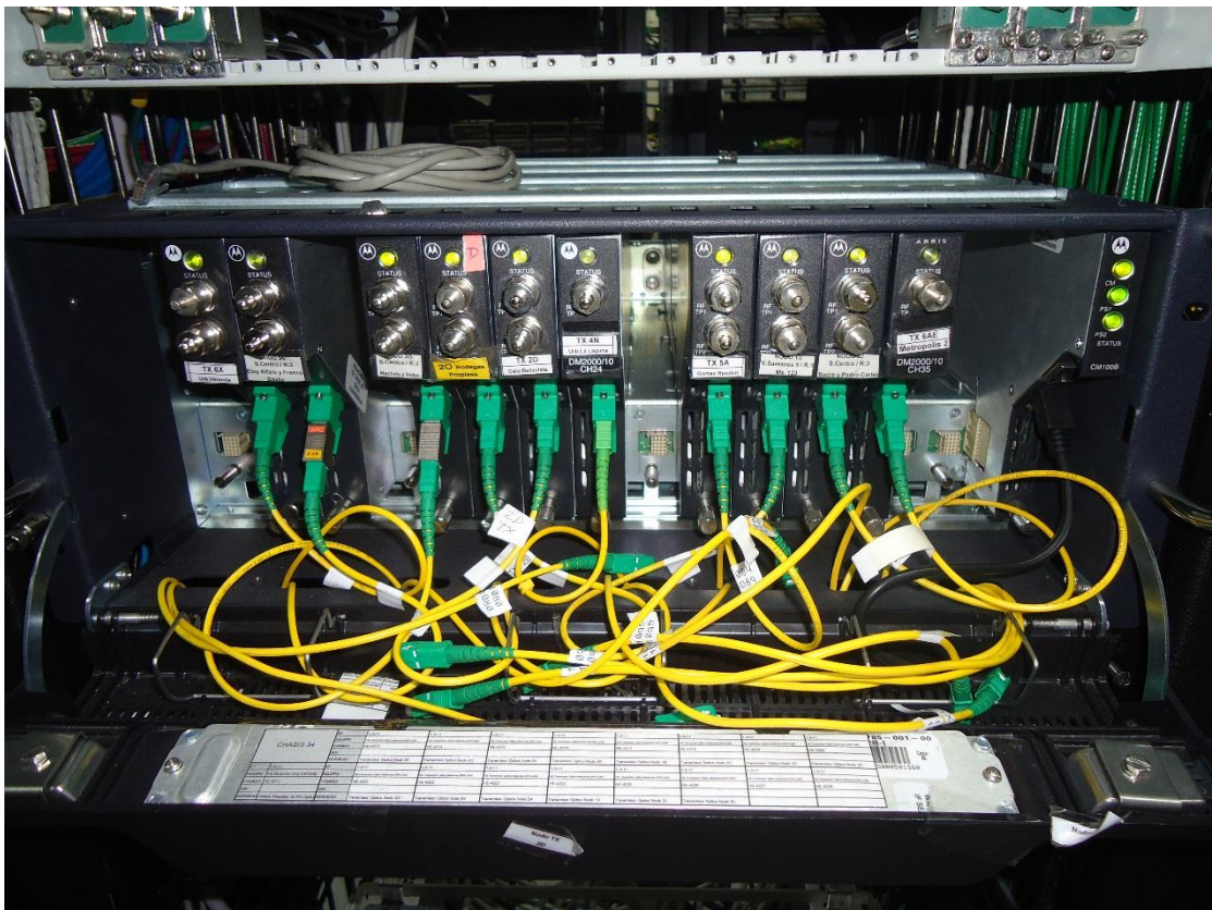
Figura 4.15. Transmisores Ópticos Fuente: (Fraga Jiménez, 2015)
