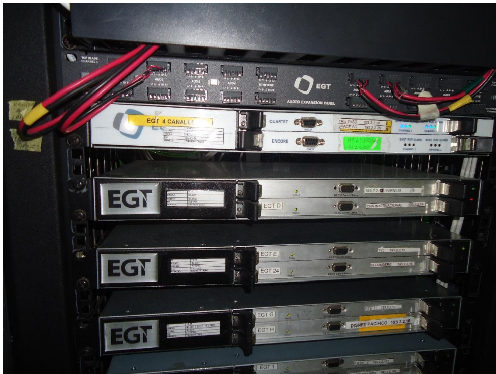
Figura 4.12. Encoder ARRIS EGT Fuente: (Fraga Jiménez, 2015)
