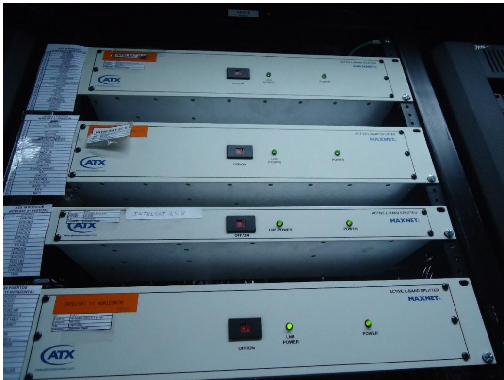
Figura 4.9. Splitter ATX Fuente: (Fraga Jiménez, 2015)
