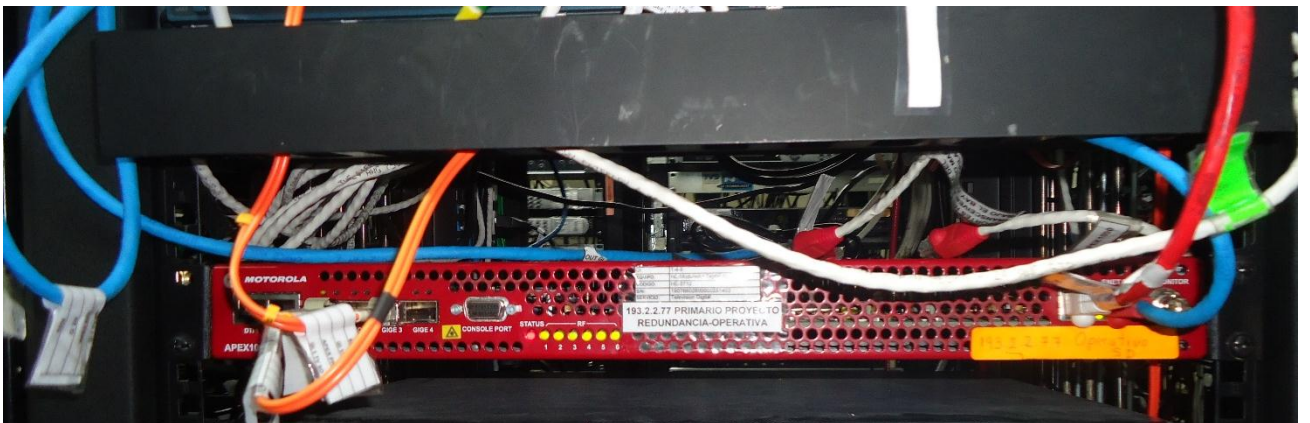
Figura 4.14. Modulador Motorola APEX Fuente: (Fraga Jiménez, 2015)
