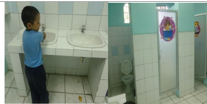
Figura 7. Baños A.N.A.I. Fuente: Vincés, (2014)
