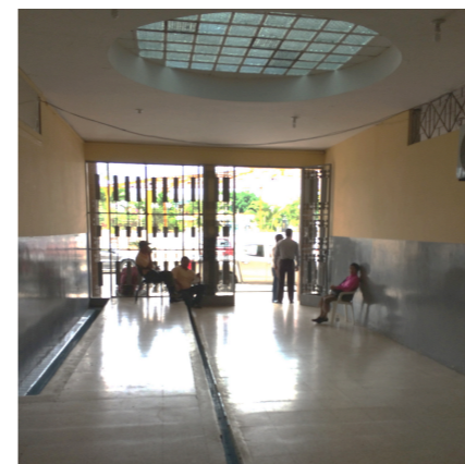
Figura 13: Escalón en pasillo principal de planta baja con ausencia de rampas. Fuente: Rosero (2014)
