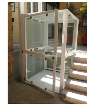
Figura 63: Ascensor para discapacitados Fuente: TecnoRampa (2014)
