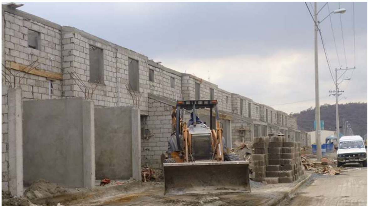
Figura 14: Vista General de villas en proceso de construcción
