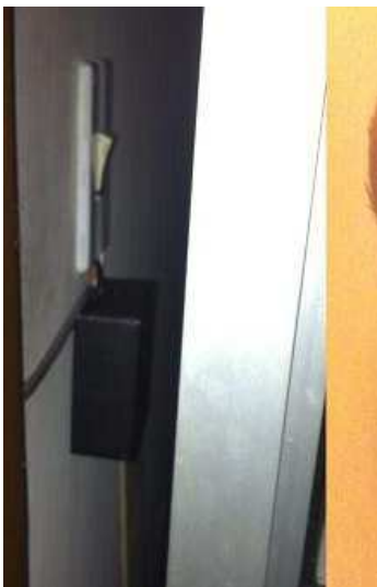
Figura 43 Instalación del circuito de Iluminación de la Oficina
