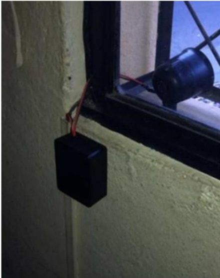
Figura 42 Instalación del Circuito de la Sirena
