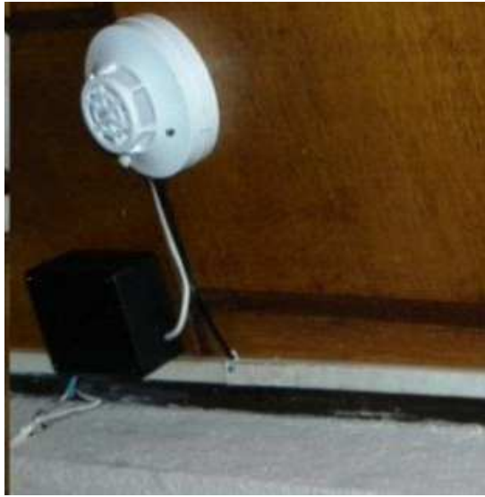
Figura 40 Instalación del Sensor de Humo
