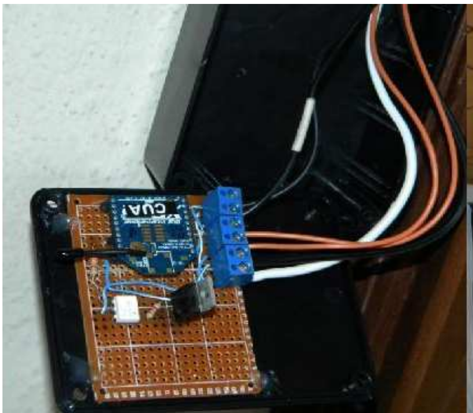
Figura 38 Instalación del circuito de Iluminación de la Habitación
