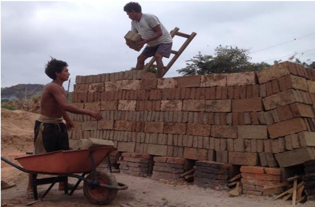
**Figura 3.18** Elaboración de la pirámide de cocción. Muestras con adiciones de lodos residuales colocadas en la pirámide de cocción.
