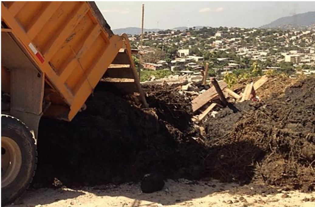
**Figura 3.7** Lodos residuales provenientes de la limpieza de canales de drenaje de AASS de Guayaquil para el relleno sanitario de Las Iguanas.
