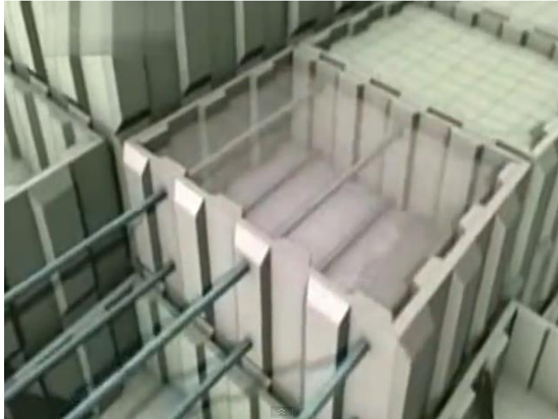
Figura 3. Cañerías por las que pasaba agua fría, bajando la temperatura de la masa de hormigón para acelerar su fraguado.
