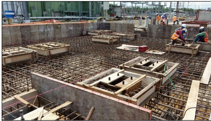
Figura 4. Encofrado de estructura en Machala Power.
