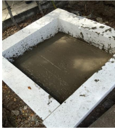
Figura 15. Hormigón fresco al finalizar fundición. (Fuente: Autor)
