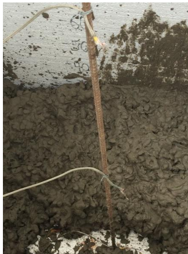
Figura 13. Cables-termocuplas fijados a distintos niveles de la masa de hormigón. (Fuente: Autor)
