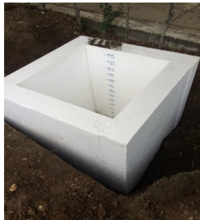
Figura 10. Configuración de planchas de poliestireno en sitio. (Fuente: Autor)
