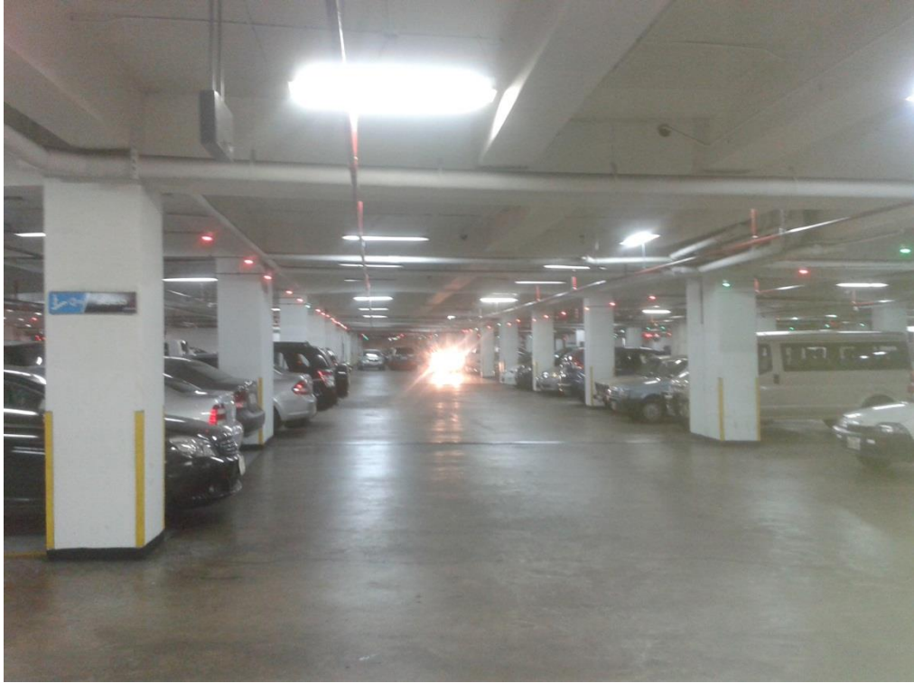
Foto #3, Parqueadero Subterráneo del Centro Comercial. Autor: Víctor Jara F.
