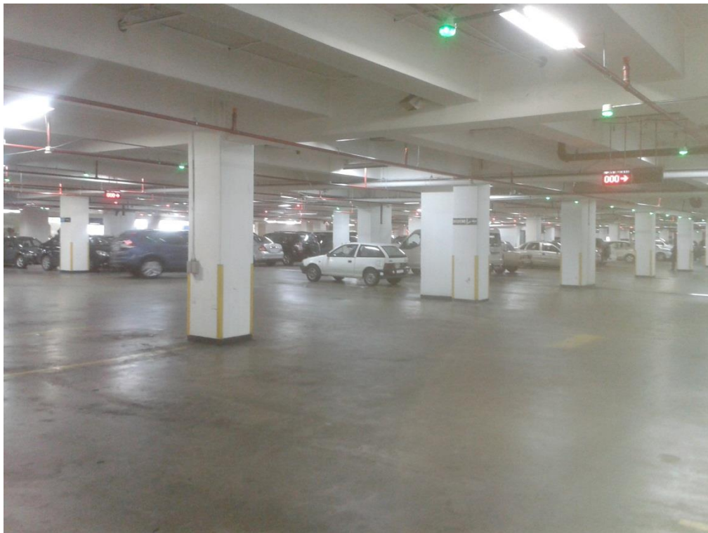
Foto #2, Parqueadero Subterráneo del Centro Comercial. Autor: Víctor Jara F.
