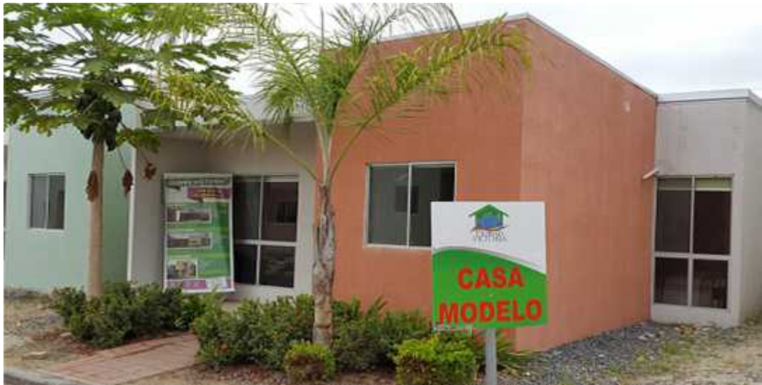
Figura 30: Local de Obra Ciudad Victoria
