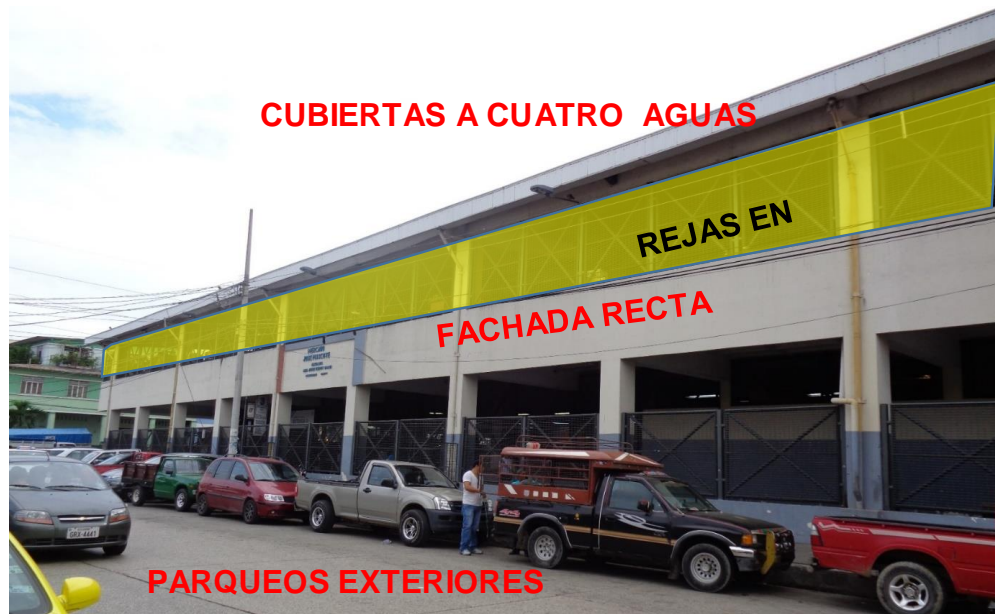
Ilustración 25 Fachada tipología 1 (Rivadeneira, 2014)
