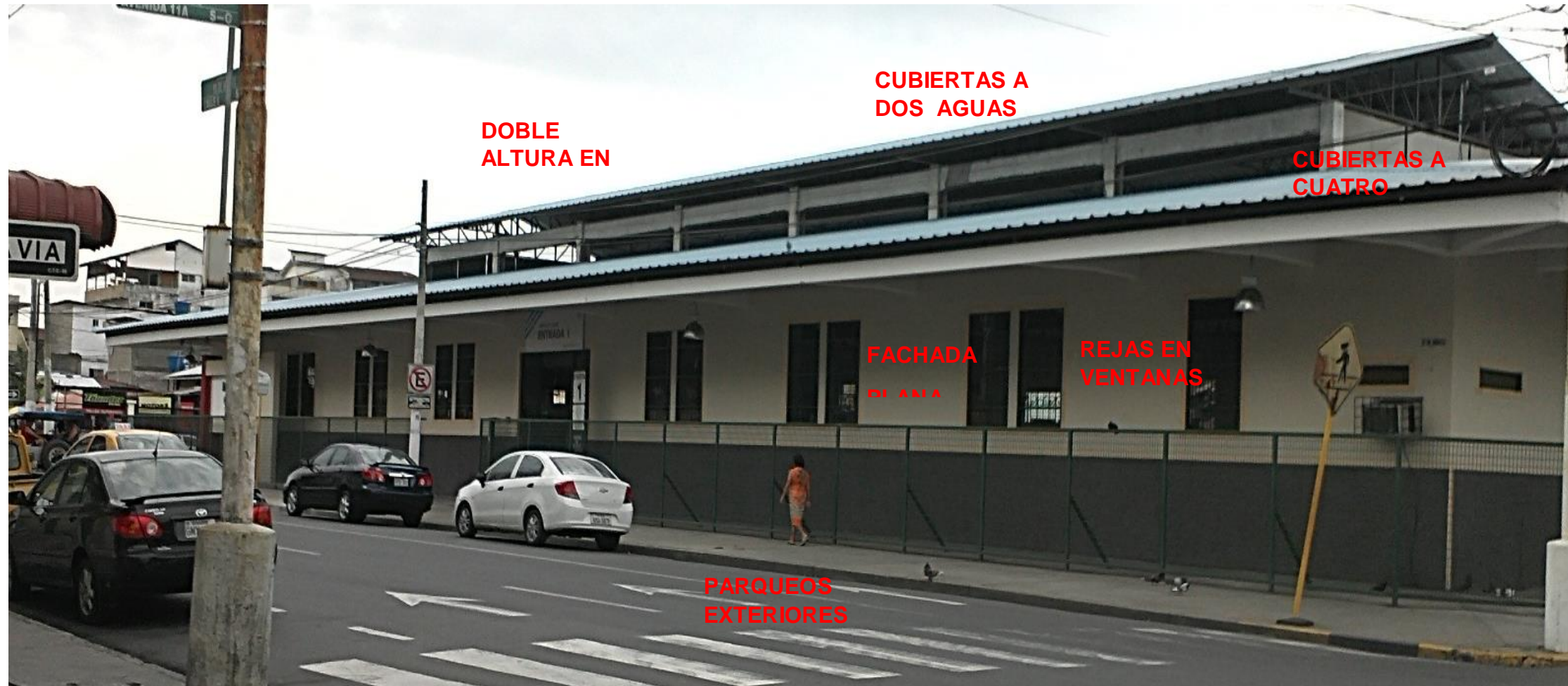
Ilustración 27 fachada tipología 2 (Rivadeneira, 2014)
