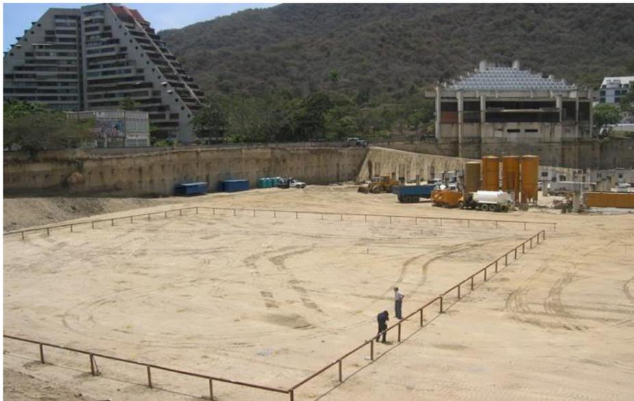
Figura 40: Proceso constructivo (trazado y replanteo)
