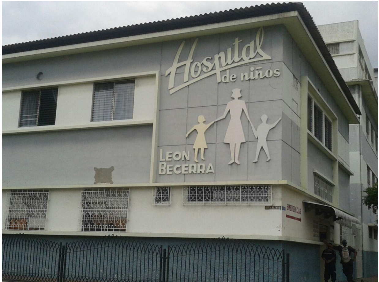
SECTOR FRENTE DEL HOSPITAL LEÓN BECERRA
