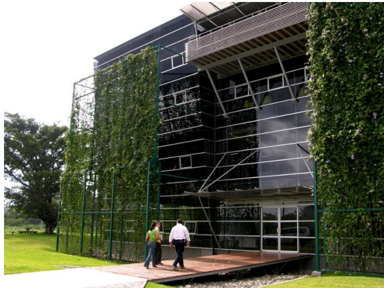
Figura 38. Ingreso principal al edificio.
