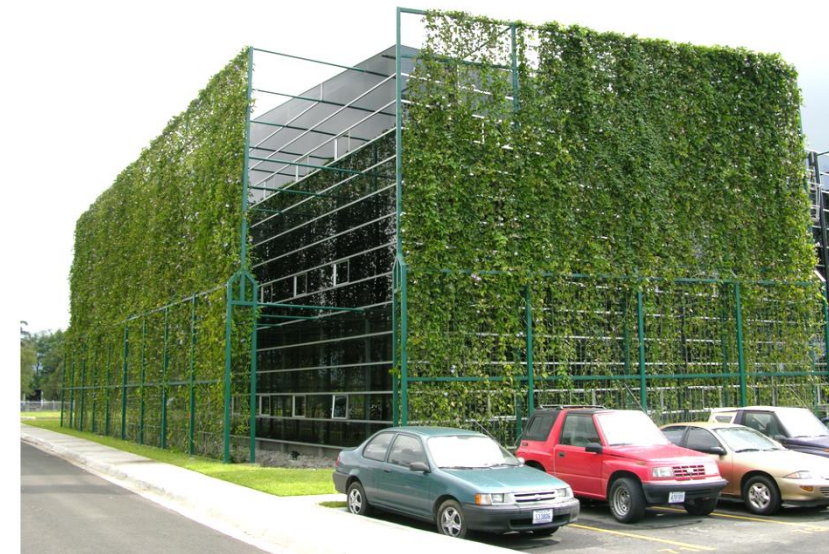
Figura 35. Tratamiento de planchas de aluminio perforado para facilitar
