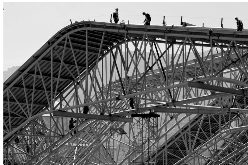
Figura 31. Proceso constructivo y detalle de tratamiento de cerchas metálicas.
