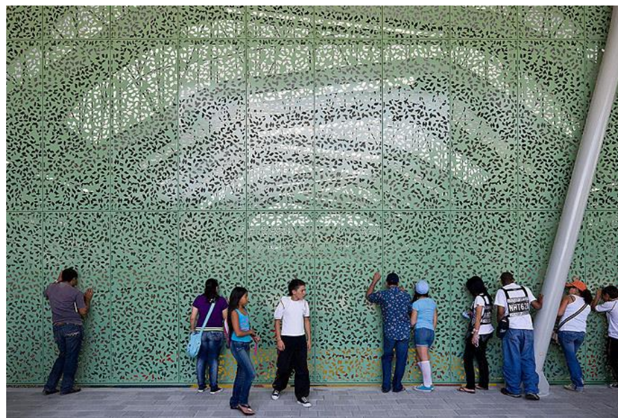
Figura 34. Tratamiento de planchas de aluminio perforado para facilitar ingreso de aire.
