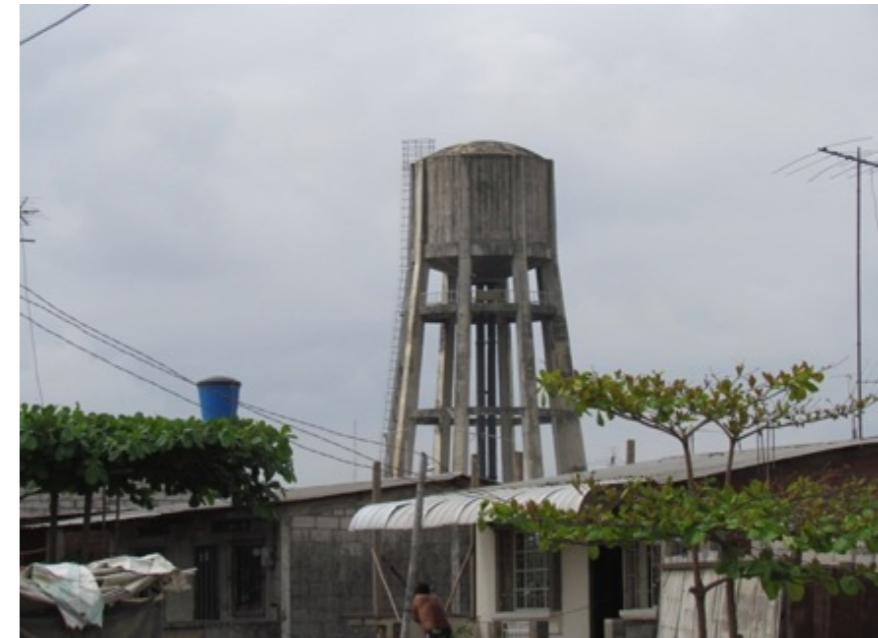
Figura 23: Tanque elevado de la Parroquia El Salto
