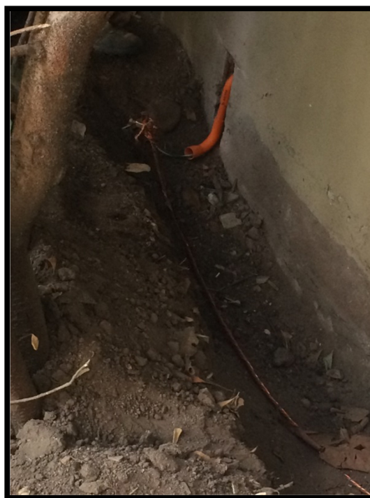
Figura 4. 5: Tendido del otro extremo de la Trenza de Cobre
