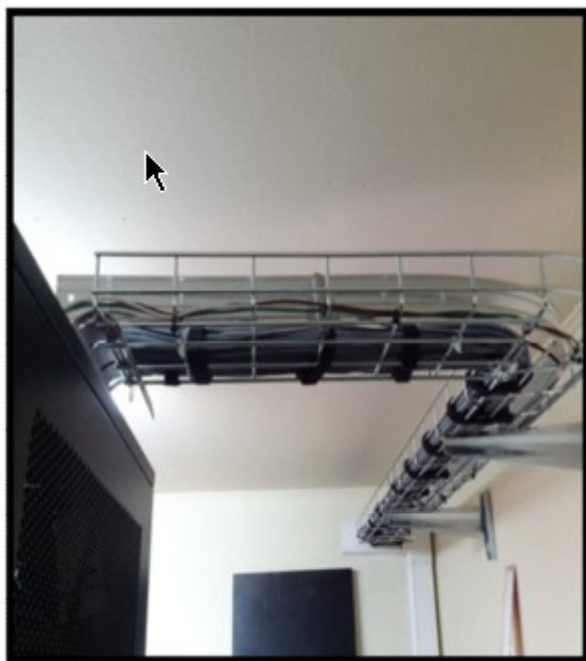
Figura 4. 18: Curvatura de la canasta o escalerilla llegando al Rack.
