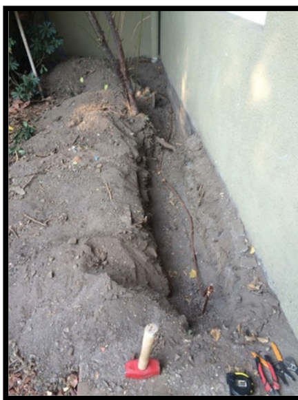
Figura 4. 4: Implantación de una Trenza de Cobre.
