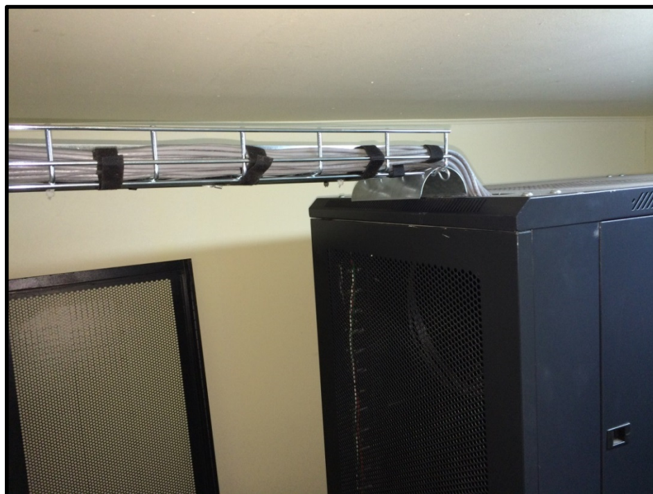
Figura 4. 18: Curvatura de la canasta o escalerilla llegando al Rack.
