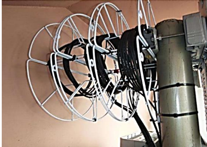
Figura 3.22: Instalación de ductos de cables Fuente: Autor
