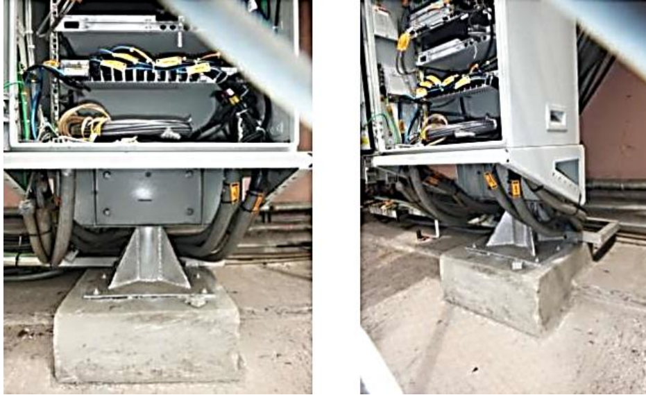
Figura 3.20: Etiquetado de cables de dato de los nuevos equipos Fuente: Autor
