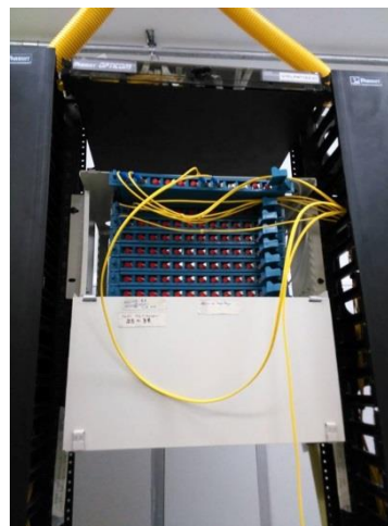
Figura 28 ODT de 96 hilos
