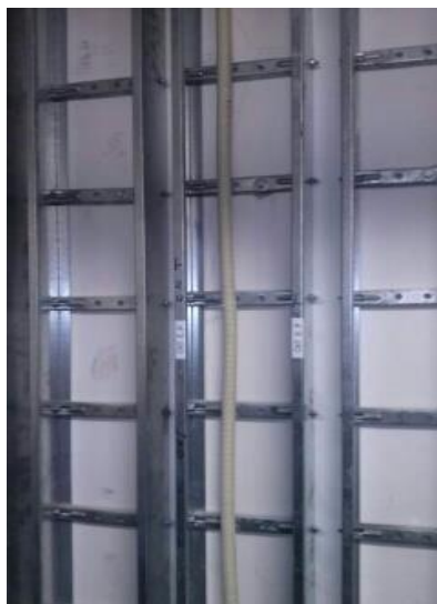
Figura 15 Ingreso de ODF con cable de 12 hilo
