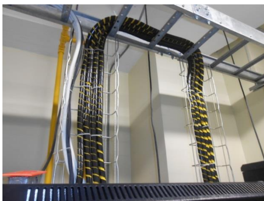
Figura 20 Instalación de Espiral Plástico
