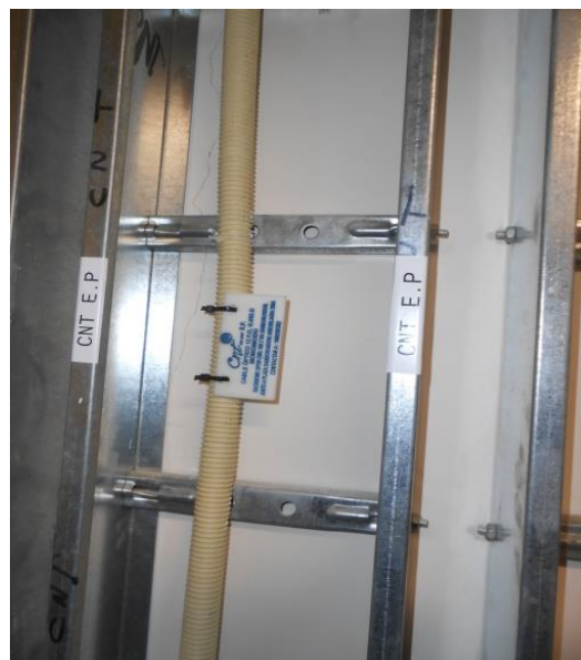
Figura 18 Instalación de Corrugado y Acrílicos
