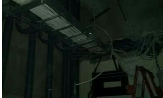
Figura 7 Instalación del Raiser al Electro canal
