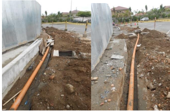
Figura 24 Canalización de Monoducto
