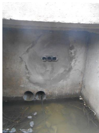
Figura 26 Instalación de Monoducto
