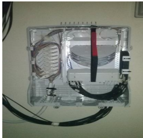
Figura 4 Cajas ópticas 24 Puertos Fuentes: El autor
