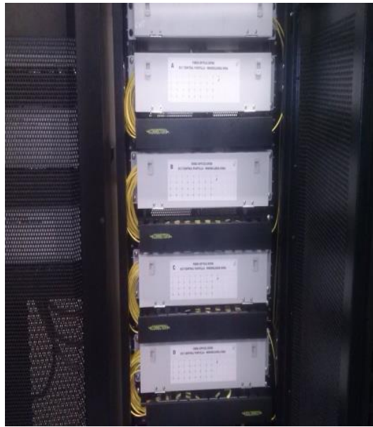
Figura 8 Instalación de ODF en los RACK
