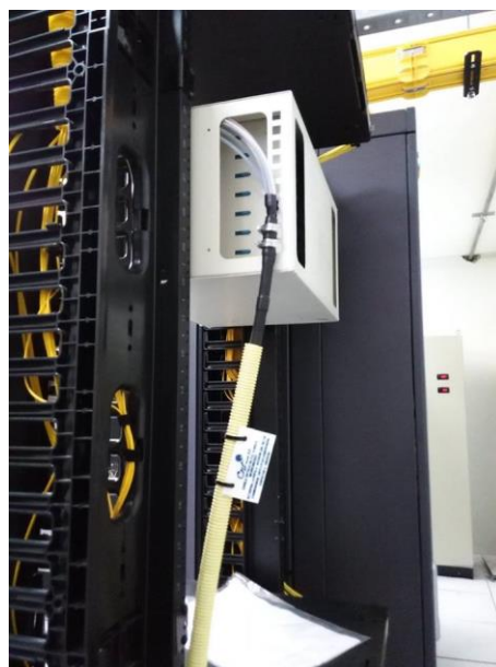
Figura 23 parte posterior del ODF de 96 hilos Fuentes: El autor
