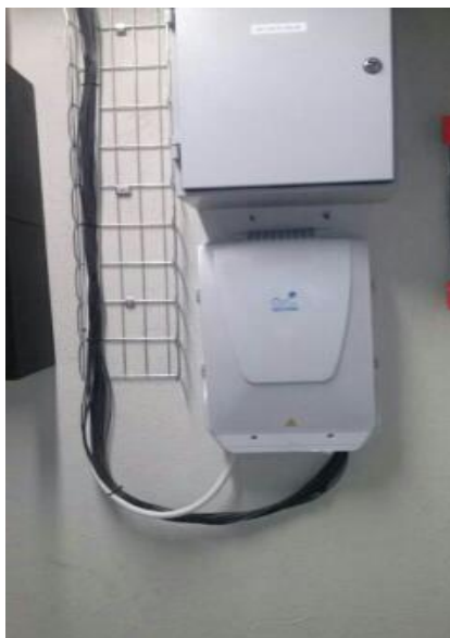
Figura 16 Caja Óptica 24 Hilos
