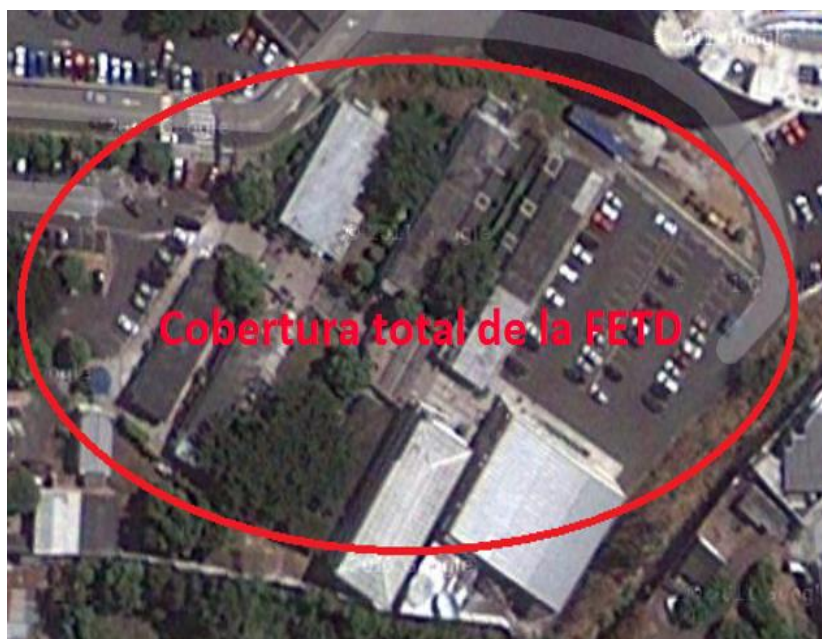
Figura 4. 14: Cobertura dentro de Facultad técnica (vista desde el aire)
