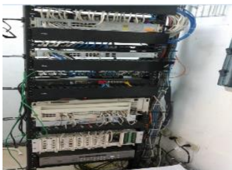
Figura 3. 12: Conexionado mediante cable en el switch principal (3).
