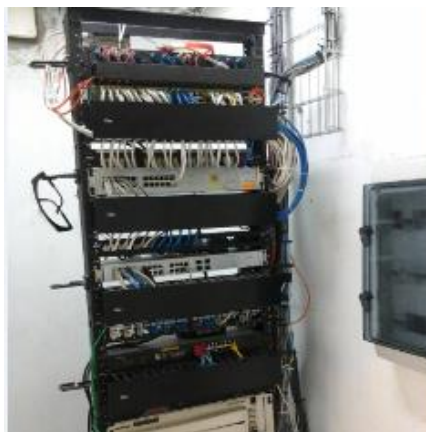
Figura 3. 11: Conexionado mediante cable en el switch principal (2).
