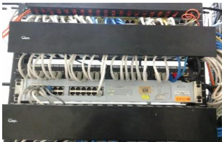
Figura 3. 10: Conexionado mediante cable en el switch principal (1).
