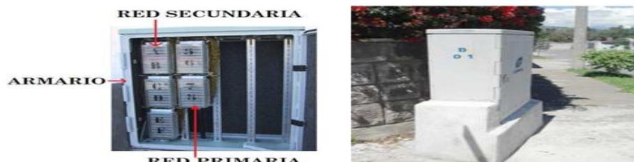
Figura 3.22: Armarios telefónicos para red primaria
