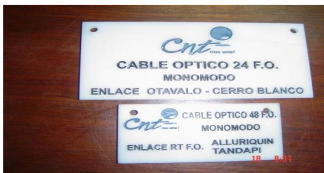
Figura 3.9: Identificador para fibra óptica
