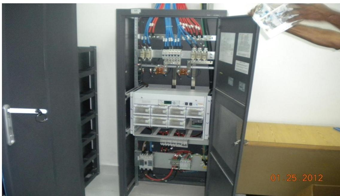
Figura 4.10: Panel de control del banco de baterías
