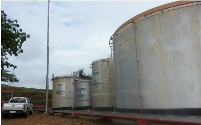
***Figura 3.3 Tanques de almacenamiento de combustible para despacho hacia bahías de carga del terminal Pascuales***
