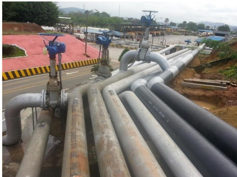
*Figura 3.2 Tuberías de conexión entre tanques de almacenamiento a tanques de despacho e islas de carga*
