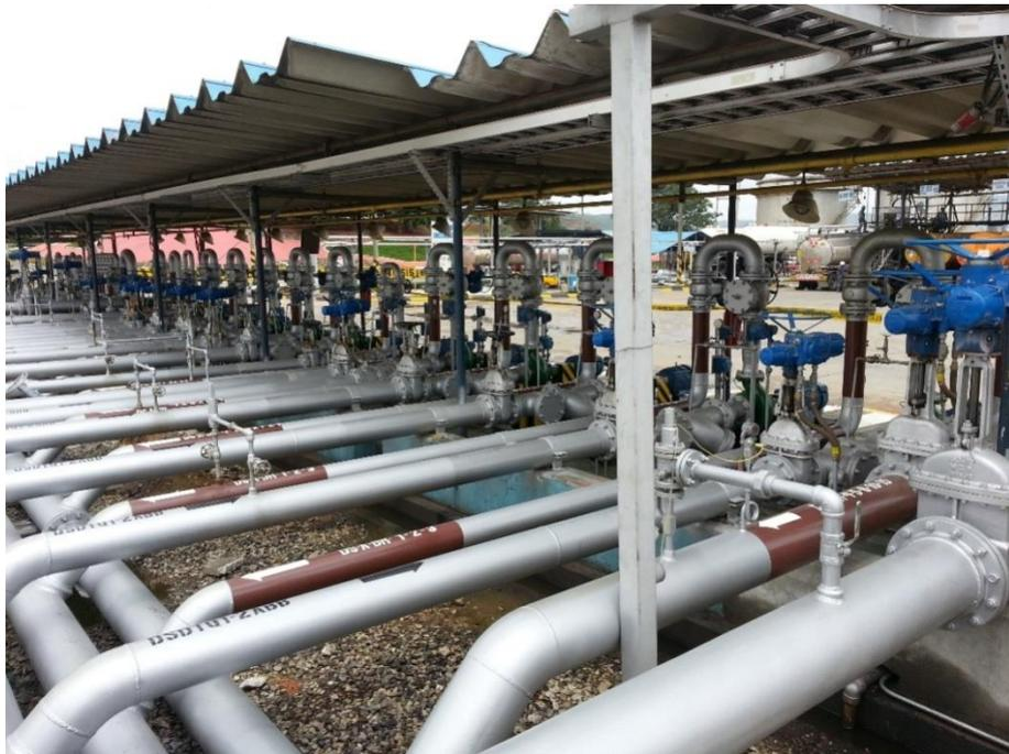
*Figura 3.5 Bombas de despacho y de descarga hacia las islas.*
