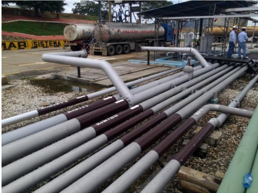
*Figura 3.6 líneas de conexión (descarga) entre bombas y brazos de despacho*
