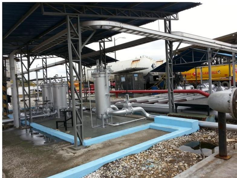
*Figura 3.8 filtrado de jet fuel en estación terminal de despacho*
