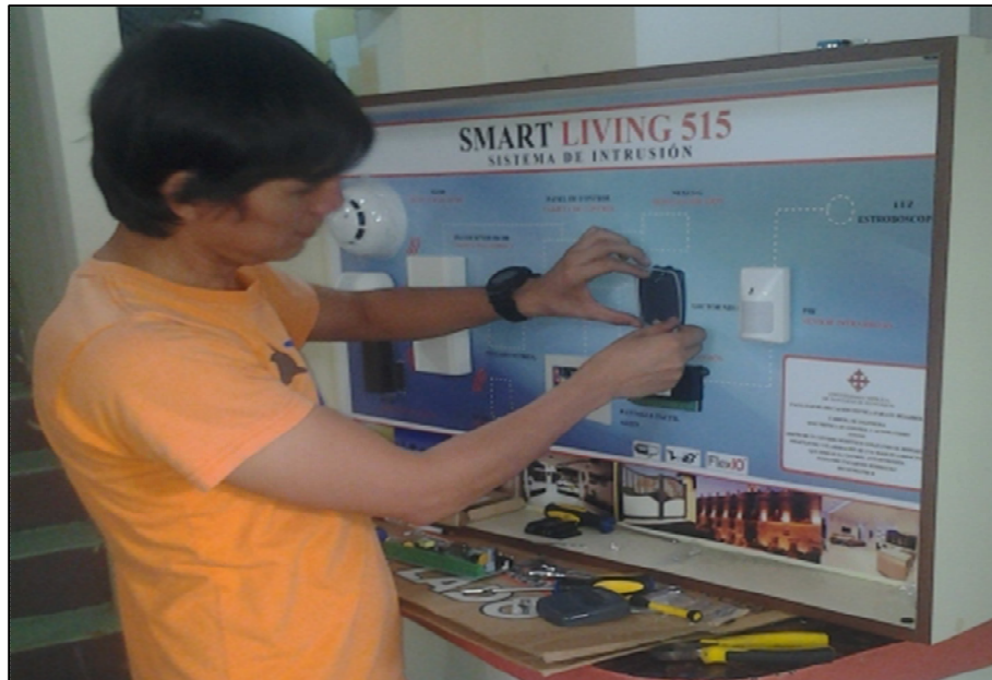
Figura 4.4 Instalación del Lector
