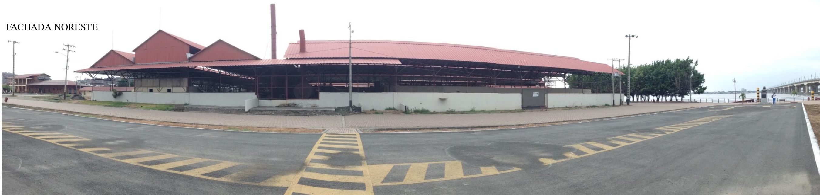
Figura 79. Vista Lateral Izquierda del Edificio Autor: Ramón (2014)
