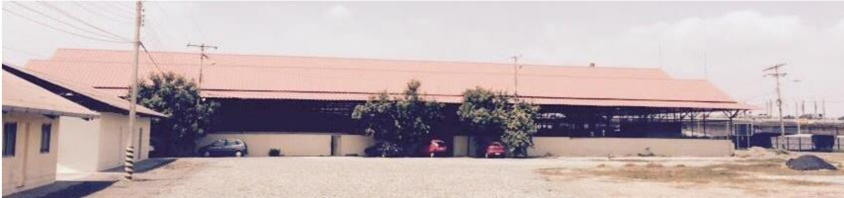
Figura 78. Vista Frontal del Edificio Autor: Ramón (2014)
