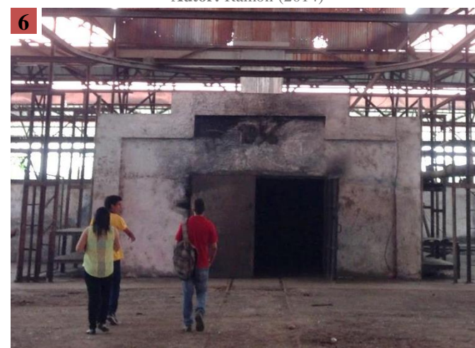
Figura 76. Caldera. Autor: Ramón (2014)
