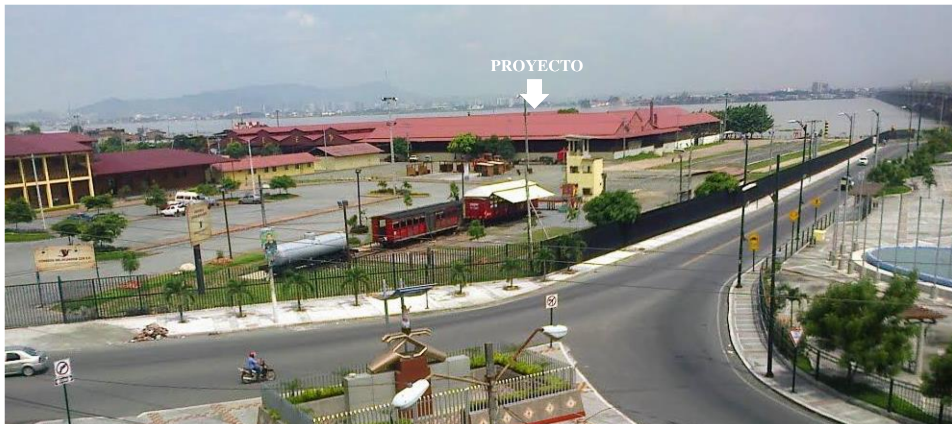
Figura 7. Vista de la estación de Durán Autor: richat777 (2013)
