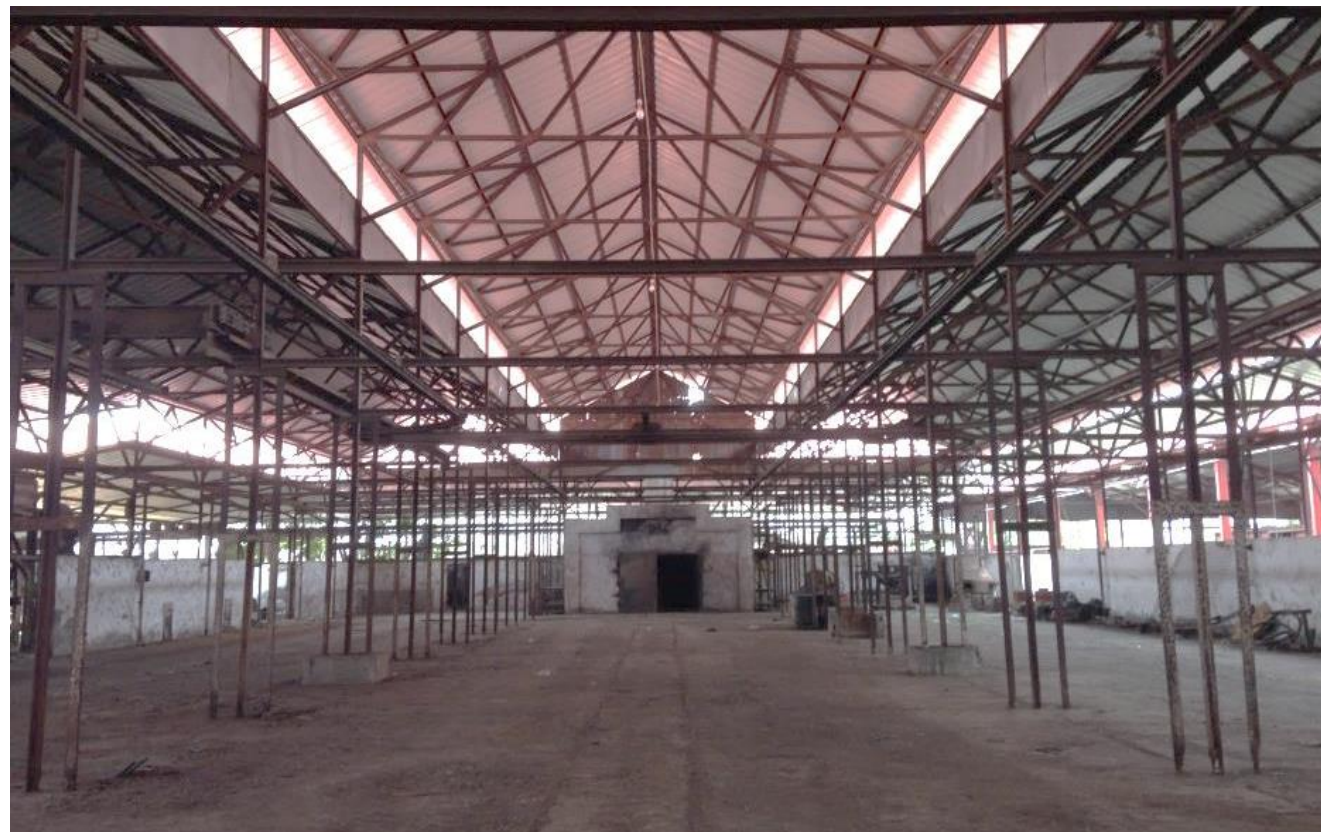
Figura 59. Vista interior del edificio. Autor: Ramón (2014)
