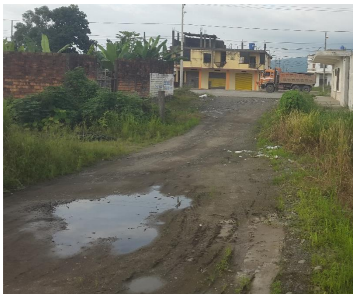
Figura 9: Vía vecinal de acceso lateral al terreno. Fuente: Giler (2104).
