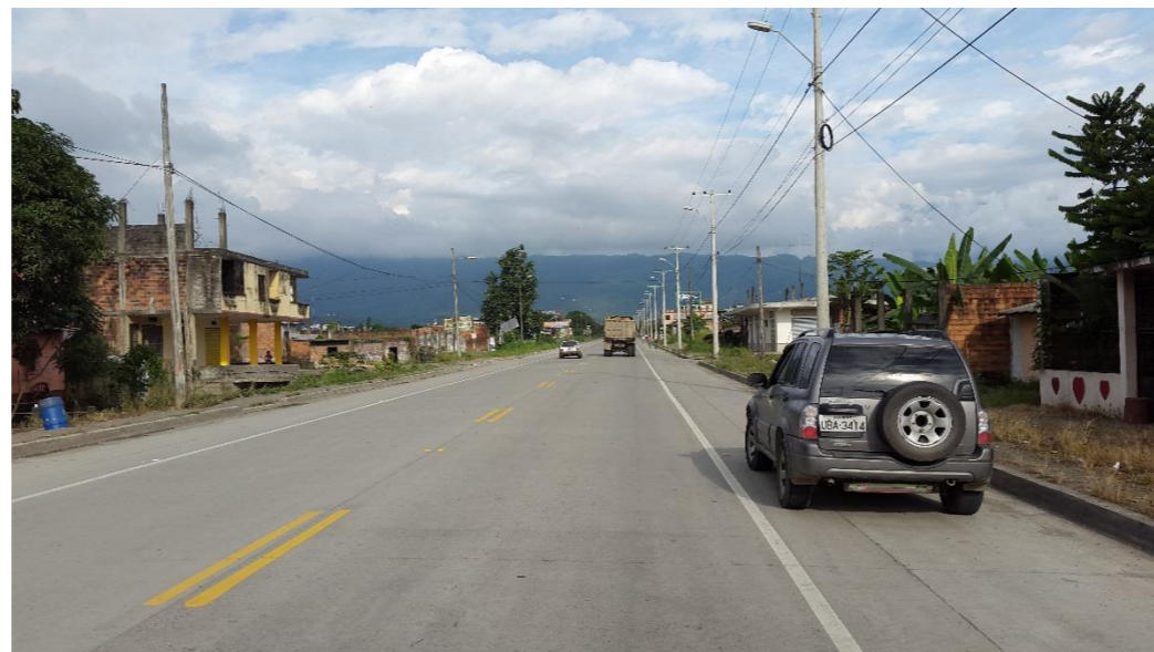
Figura 10: Vía Principal de acceso al terreno (Km 73 Vía Durán – Tambo). Fuente: Giler (2104).
