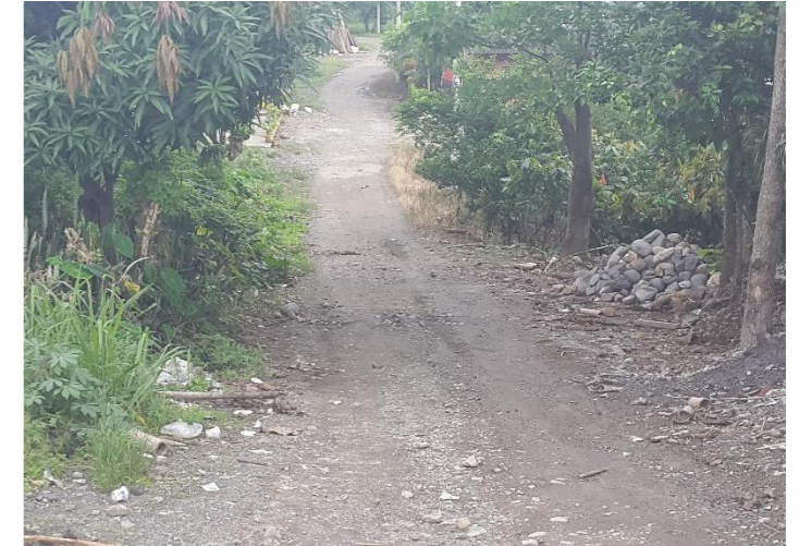
Figura 11: Vía vecinal de acceso lateral al terreno. Fuente: Giler (2104)..
