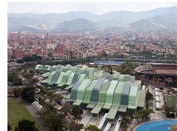
Figura 65: Panorámica interior coliseo.
