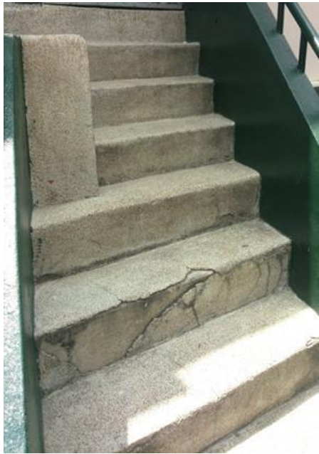
Figura 12: Escaleras de acceso a las aulas.
