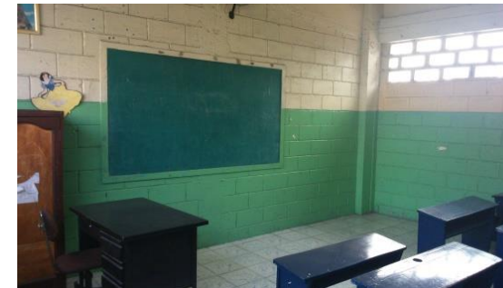
Figura 15: Paredes de las aulas.
