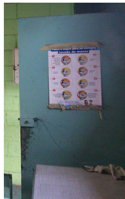
Figura 19: Puerta de acceso a aula.
