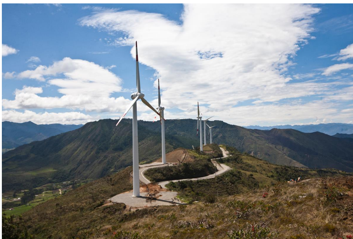
Figura 2.4 Parque eólico Villonaco
