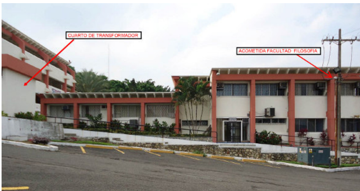
Figura 3.2 Ruta de alimentación eléctrica de Facultad de Filosofía y Ciencias de la Educación. Elaborado: Autor
