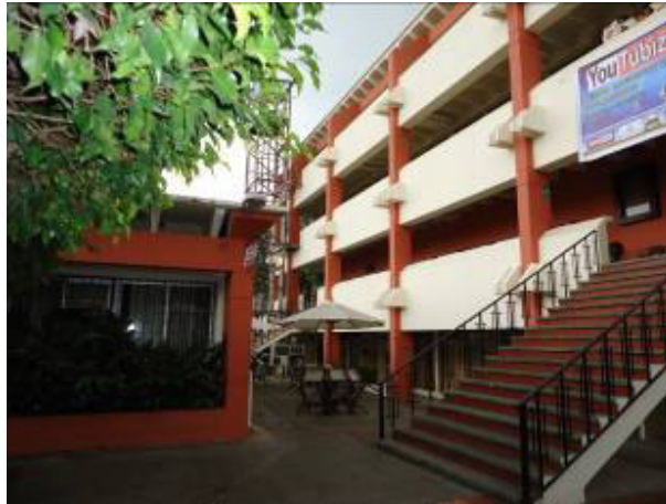
Figura 1.2 Edificio Aulas / Laboratorios. Elaborado: Autor
