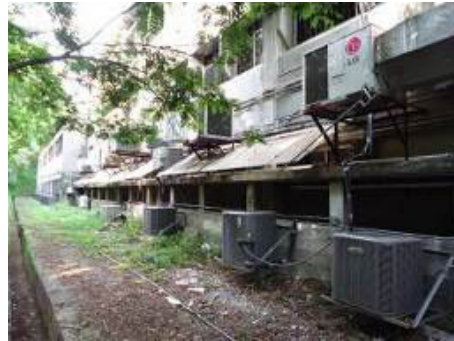
Figura 3.29 Parte posterior del Edificio Aulas/Laboratorios. Elaborado: Autor
