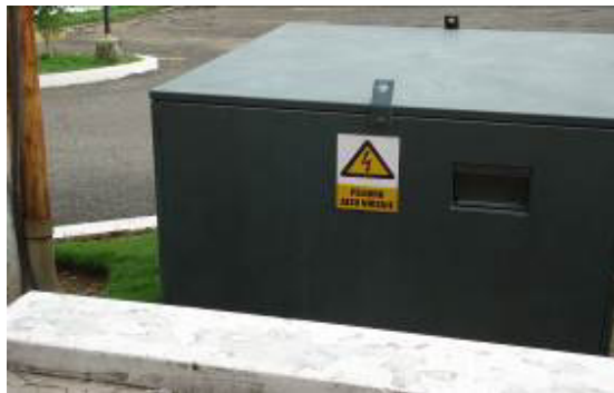
Figura 3.3 Pad Mounted Swithgear de Facultad de Filosofía y Ciencias de la Educación.
